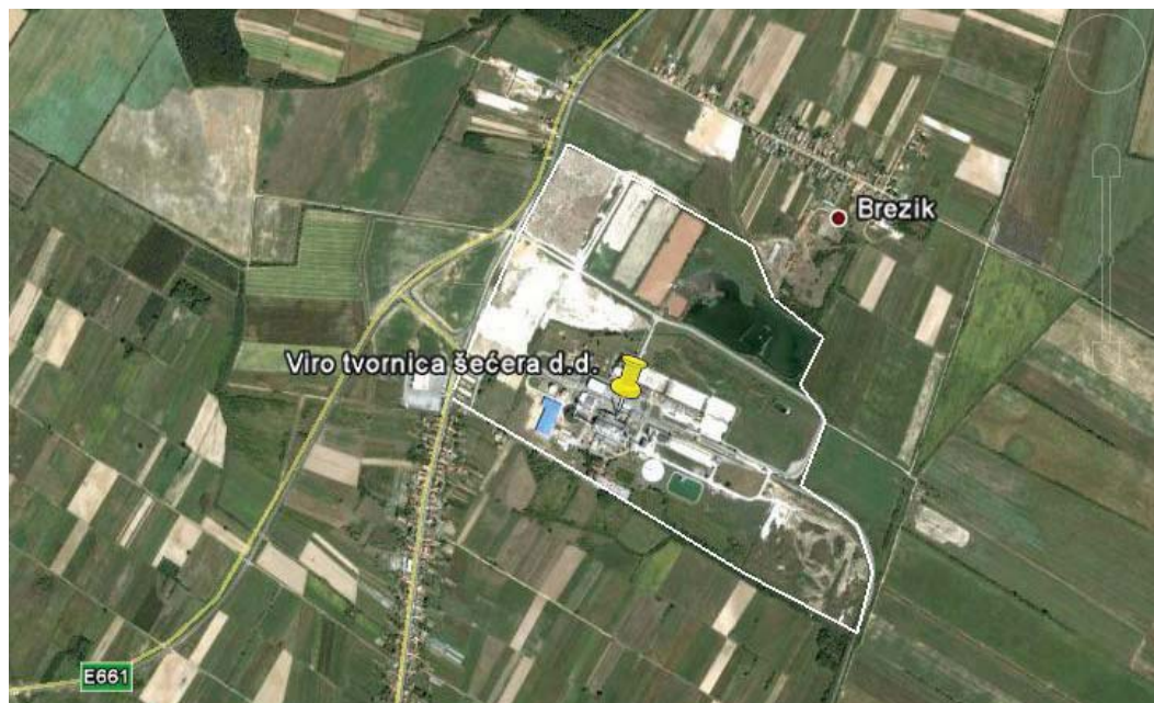
Slika 12. Pogled iz zraka na lokaciju VIRO Tvornice šećera d.d. Virovitica
